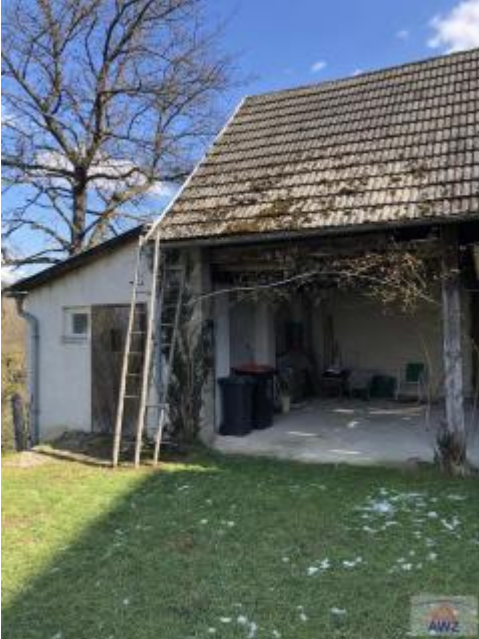
Hofeinfahrt, Carport, Geräteschuppen
